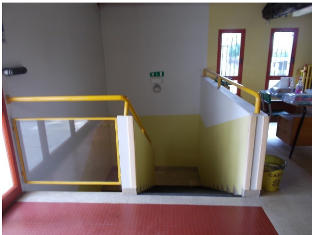
Parapetto scala P1
