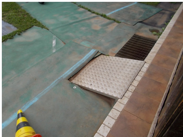
Particolare rampa accesso servizi
