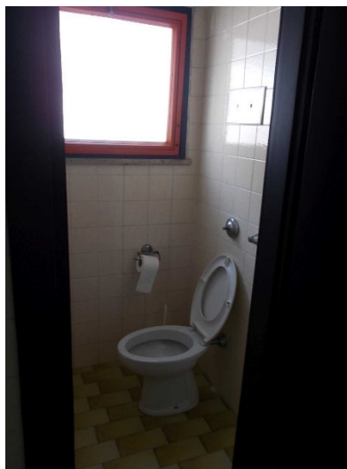
Dettaglio servizi Igienici
