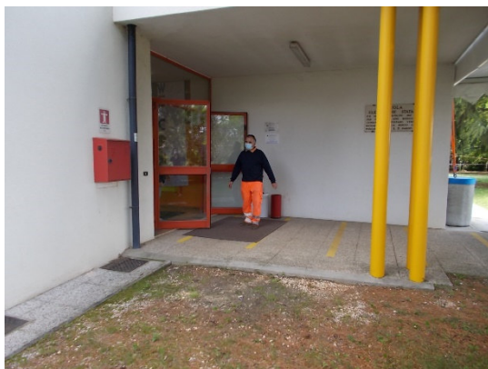
Esterno porta ingresso
