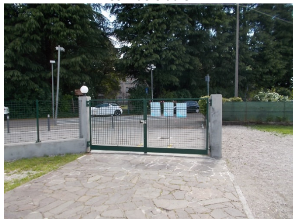
Dettaglio cancello accesso
