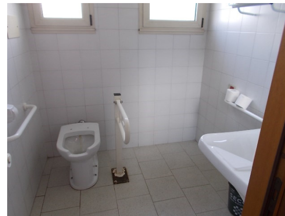
Dettaglio servizi igienici
