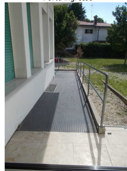
Rampa accesso secondario
