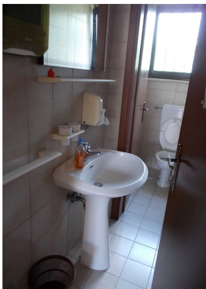
Dettaglio servizi igienici
