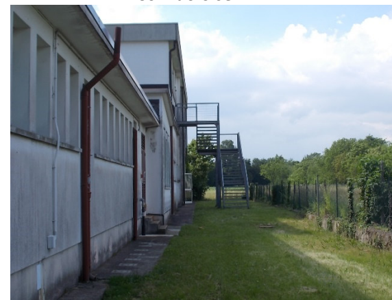
Area esterna scala sicurezza
