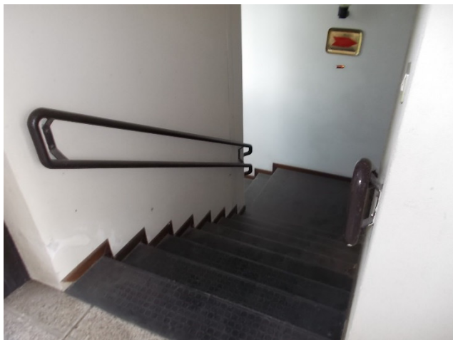
Rampa scale per Piano Interrato
