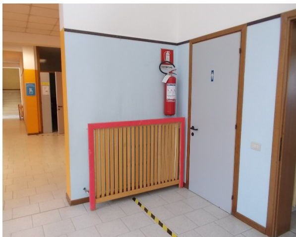
Particolare nicchia radiatore
