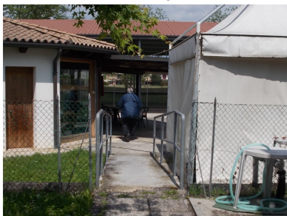
Rampa per accesso porzione esterna
